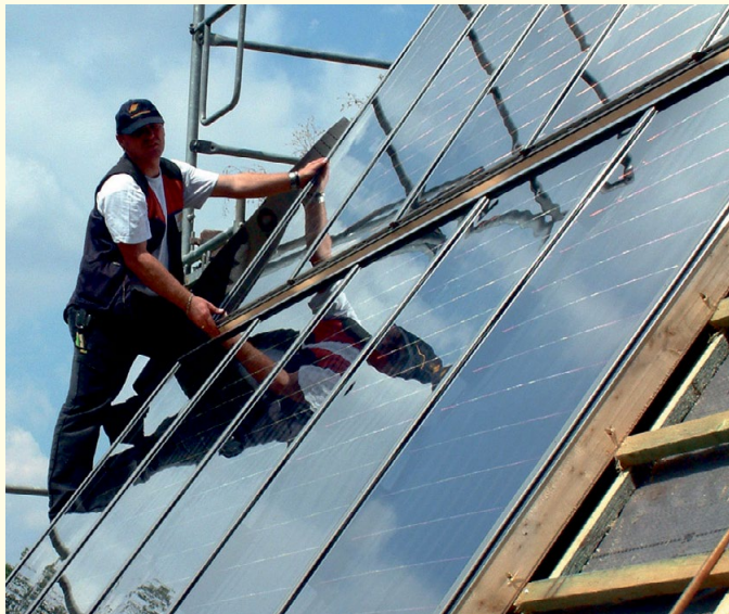
Photovoltaik: Dachdecker wissen, was zu tun ist. Foto: HF, Redaktion Harald Friedrich/akz-o
